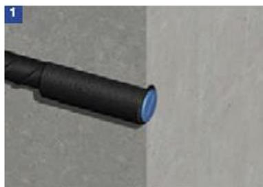
1 LE BOCCOLE (MANICOTTI) VENGONO INSTALLATI SULLE BARRE DI ARMATURA E ADEGUATAMENTE TAPPATE, PRONTE PER LA SUCCESSIVA FASE DI GETTO
