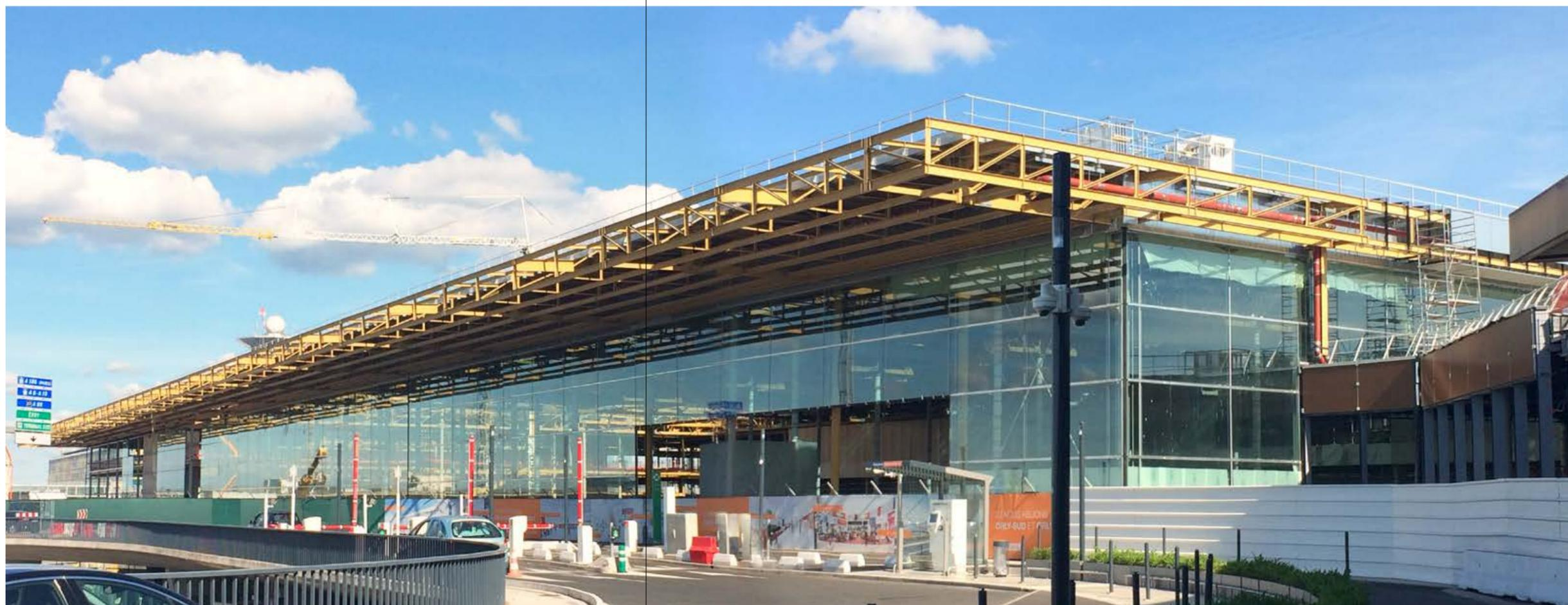
▲ Terminal in fase di costruzione: montaggio delle vetrate di facciata e dei rivestimenti esterni ed interni alla struttura
