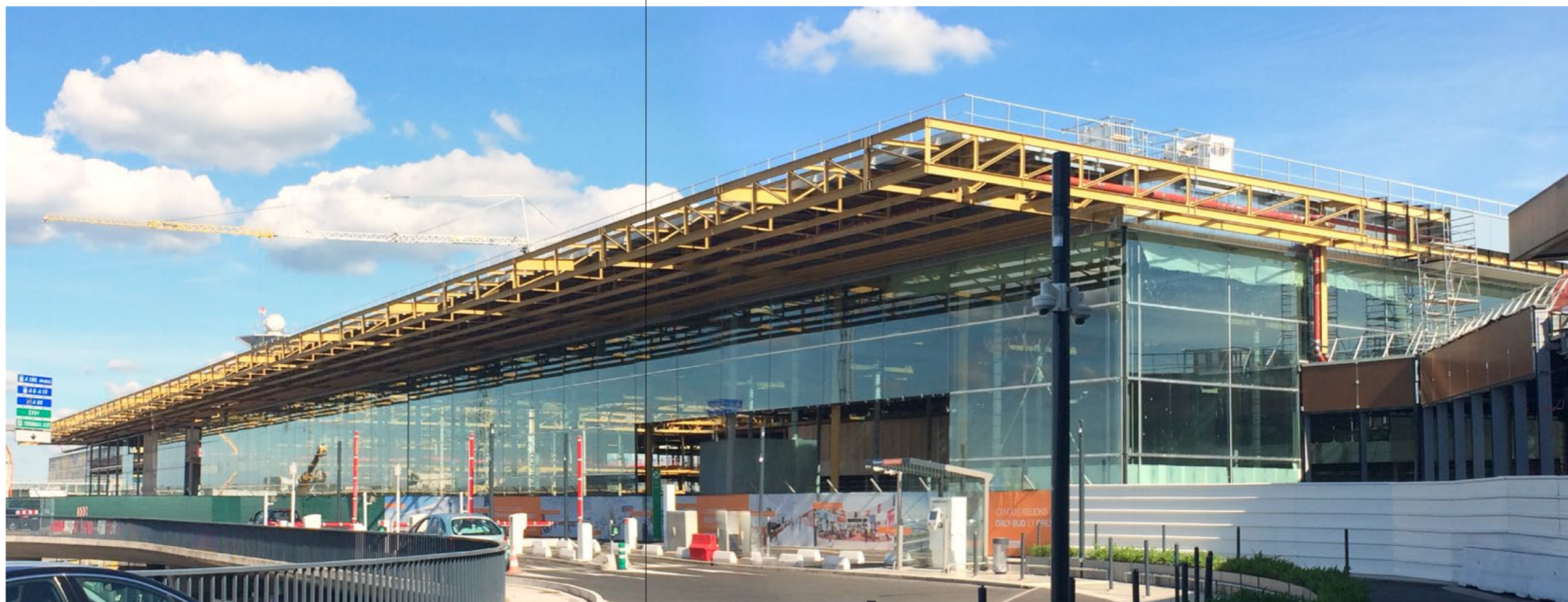
▲ Terminal in fase di costruzione: montaggio delle vetrate di facciata e dei rivestimenti esterni ed interni alla struttura Terminals under construction: installation of façade glazing and external and internal cladding
