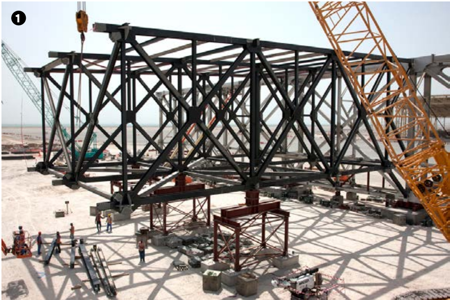
► Fasi costruttive di un arcareccio in reticolare spaziale. Si notino le dimensioni enormi rispetto alle tradizionali carpenteie metalliche. Construction stages of a spatial lattice purlin. Note the enormous dimensions compared to traditional metalwork.
