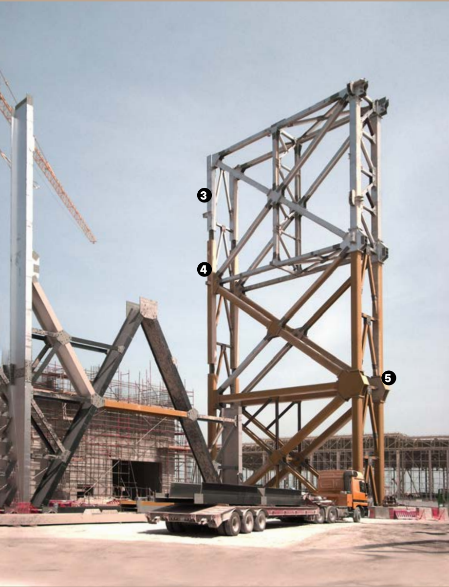
▲ Fasi di montaggio di una colonna del portale principale. Assembly stages of a main portal column.
