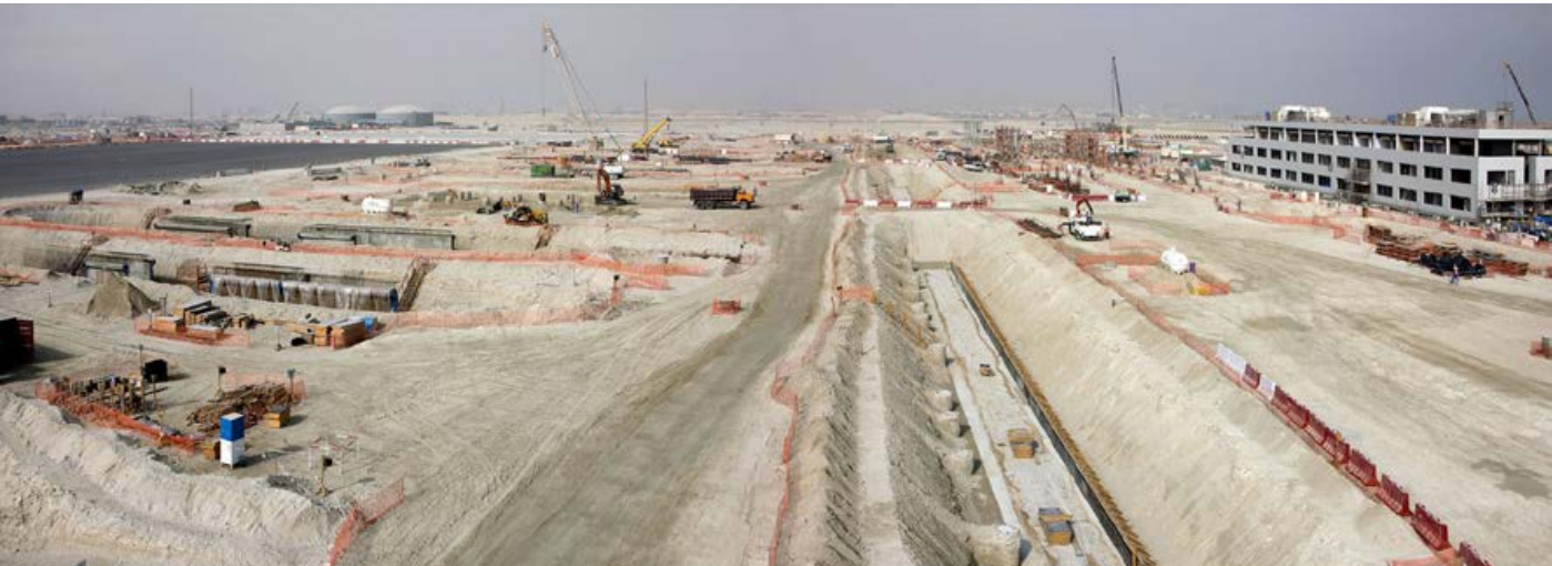
▼ Veduta aerea di cantiere in fase di scavo e gettata delle fondazioni. Aerial view of site during excavation and foundation casting.
