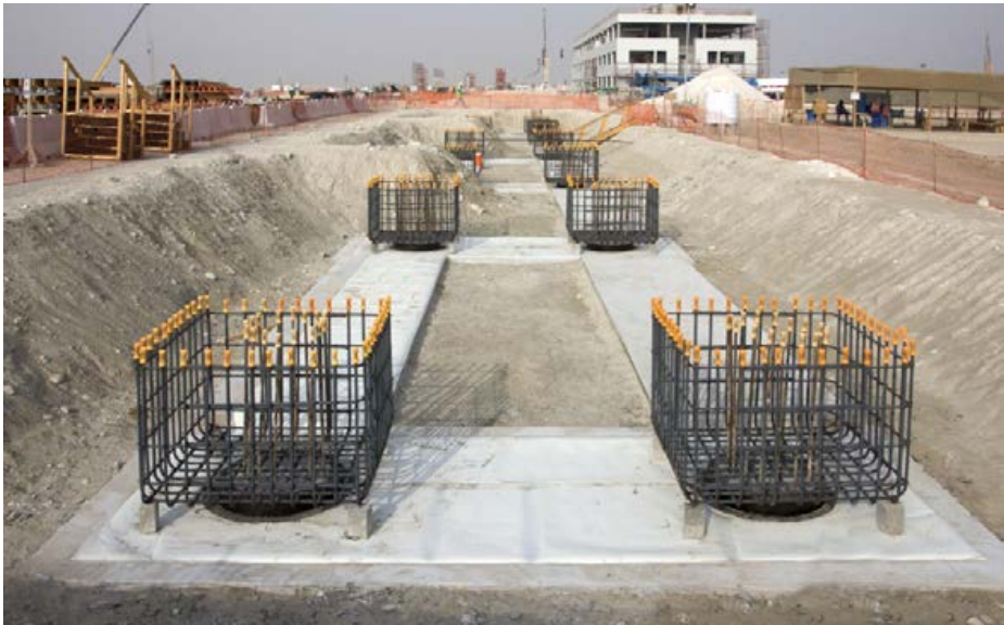
◀ Viste generali dell'area e installazione e avanzamento lavori delle colonne posteriori adiacenti all'area workshop. General views of the area and installation and progress of the rear columns adjacent to the workshop area.
